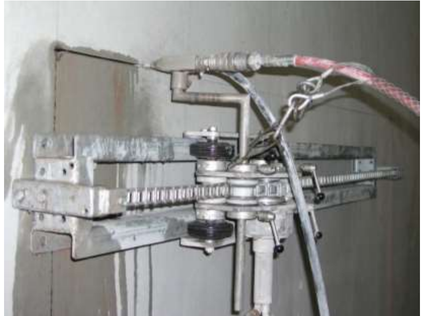
MUR EN BETON ARME
