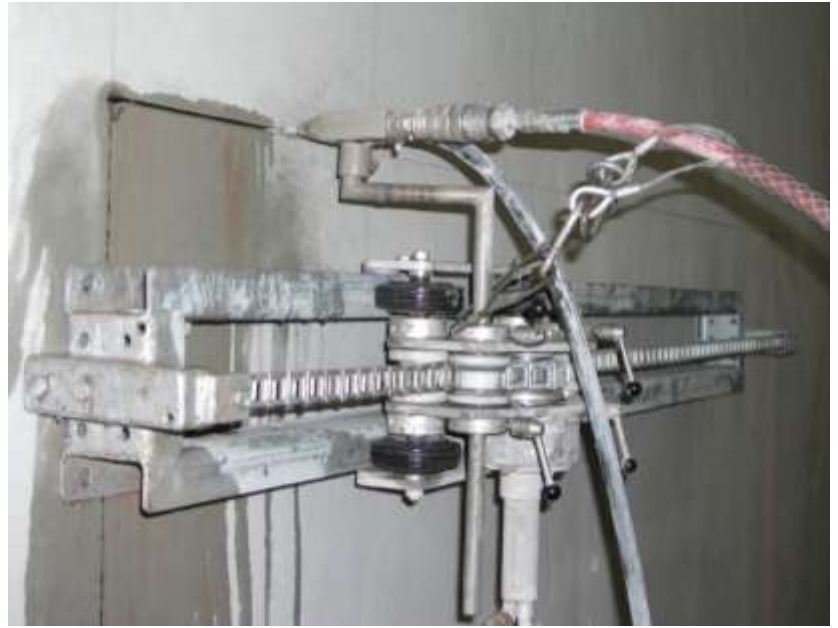
MUUR UIT GEWAPEND BETON
