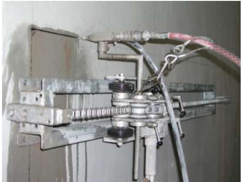
MUR EN BETON ARME
